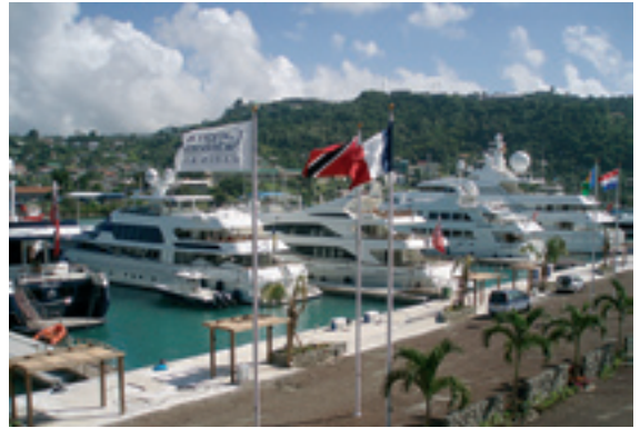
Marinetek byggde superjakt-hamnen i Grenada, Karibien.
